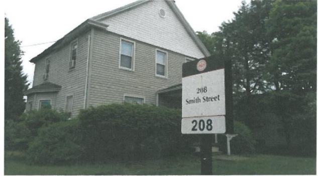
208 Smith Street (Vacant)
